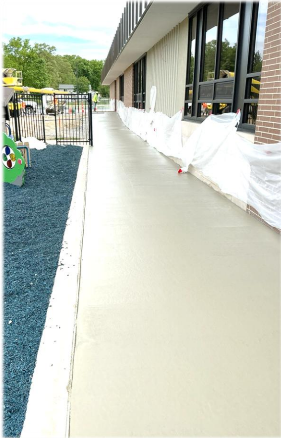
Sidewalk Concrete Pour
